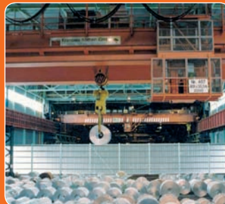
4- Кран с высокой грузоподъемностью.
